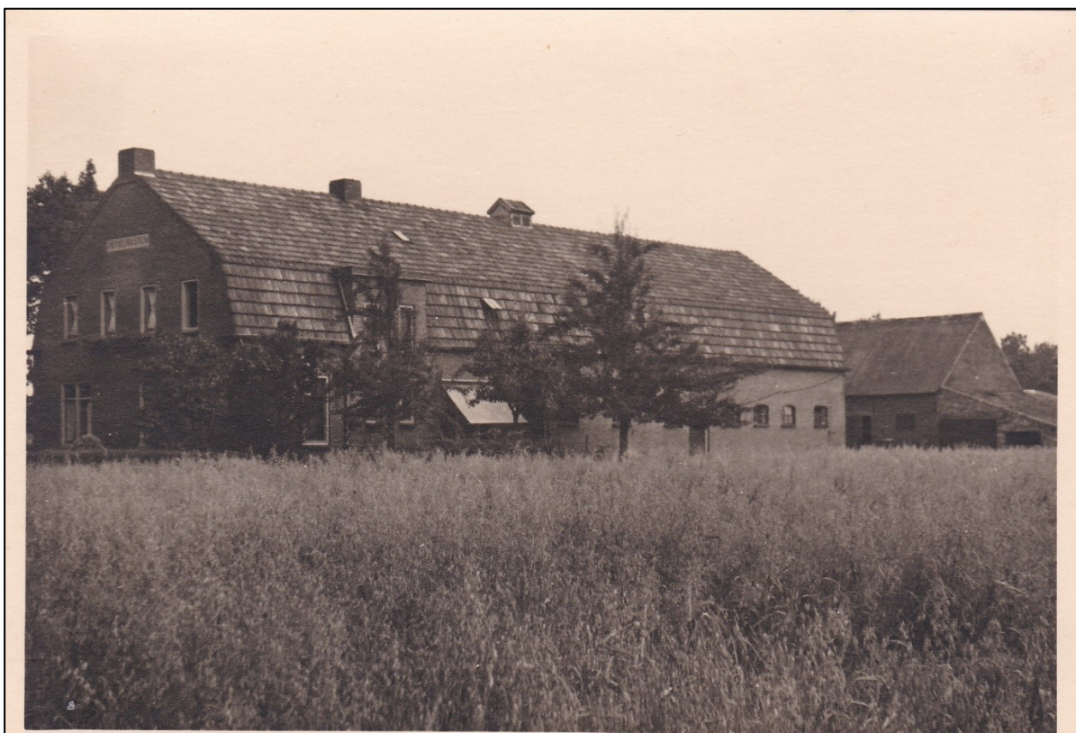
Achterzijde Hemelrasten, gezien vanaf de Heezerweg
